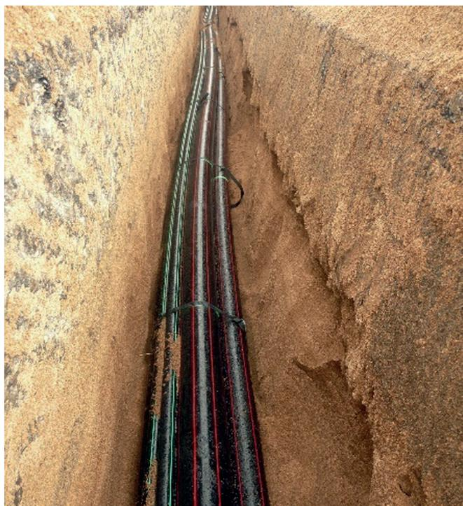
Figure 21 : Pose de câbles souterrains en fourreaux polyéthylène haute densité (PEHD) en zone rurale
