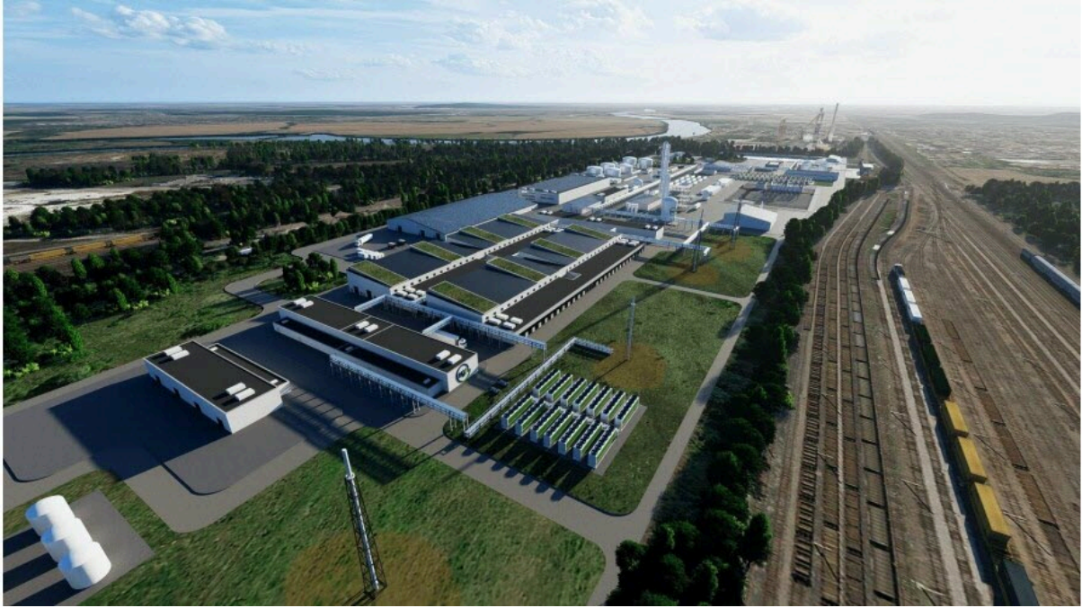
Une projection de la future usine de production d'hydrogène vert et d'e-méthanol, sur la partie uckangeoise de l'Europort. Photo H2V
